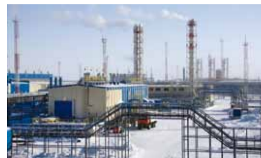
Газовый промысел №2 Бованенковского месторождения
