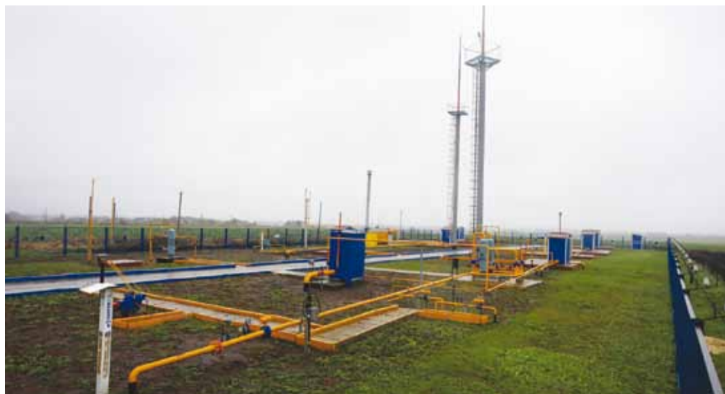
Все газораспределительные станции, подключенные к магистральным газопроводам, имеют резервное питание. Тем самым обеспечивается стабильность и бесперебойность газоснабжения потребителей
