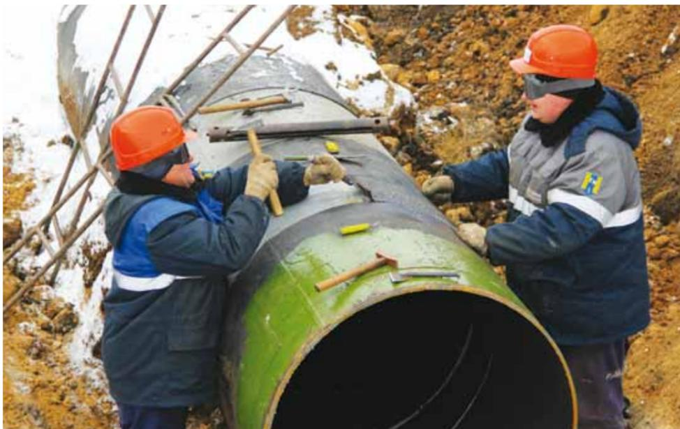
Снятие изоляции трубопровода выходного шлейфа КС-1 для проведения сварочно-монтажных работ.
