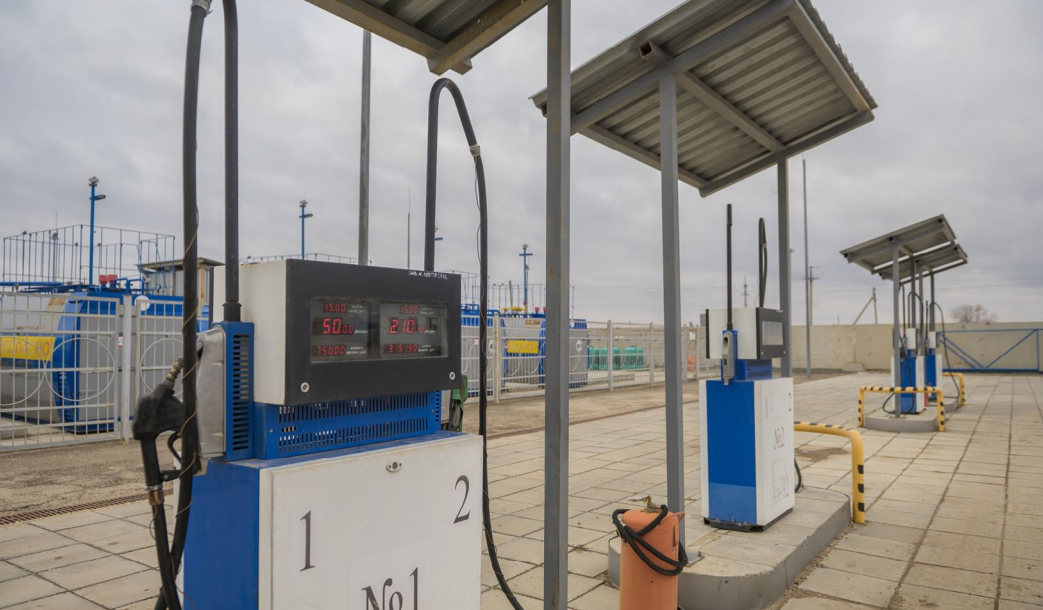
Топливо-заправочный пункт автоколонны № 5 УТТиСТ
