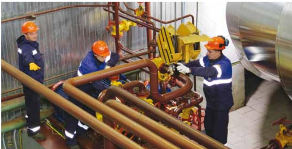
Работники КС Р. Линьков, Д. Ткачев и Д. Железнов выполняют ремонт винтовых масляных насосов уплотнения на ГПА
