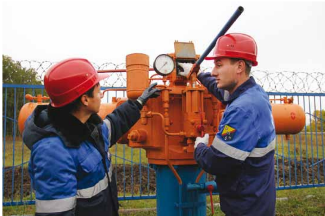
Инженер по эксплуатации оборудования газовых объектов Р.Байбиков и мастер Т.Фурукин выполняют техническое обслуживание трубопроводной арматуры
