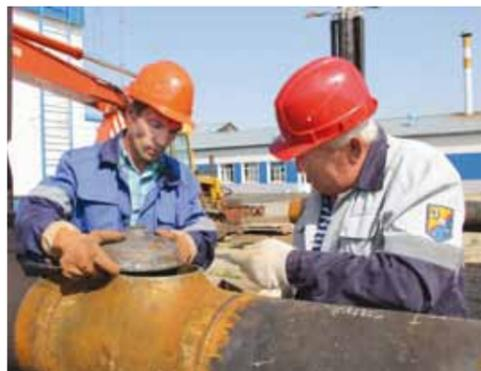
Линейные трубопроводчики А.Климов и А.Каблов выполняют монтаж кранового узла
