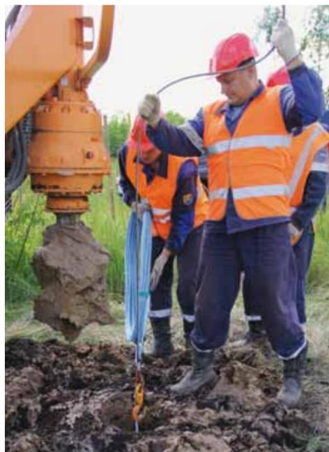
Электромонтер службы защиты от коррозии Сергей Ишеев проводит монтаж электрода анодного заземления на МГ САЦ-1
