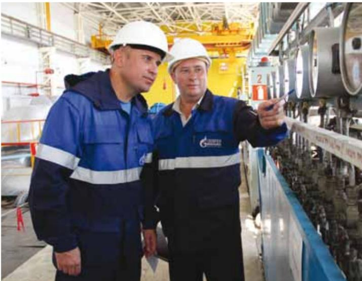
Инженер отдела охраны труда Р. Степанов и начальник ГКС Юрий Тимонин проверяют наличие штампов на манометрах в компрессорном цехе КС-1
