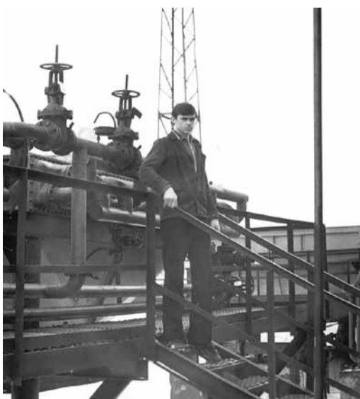
Н.Скрипаль на компрессорной станции
