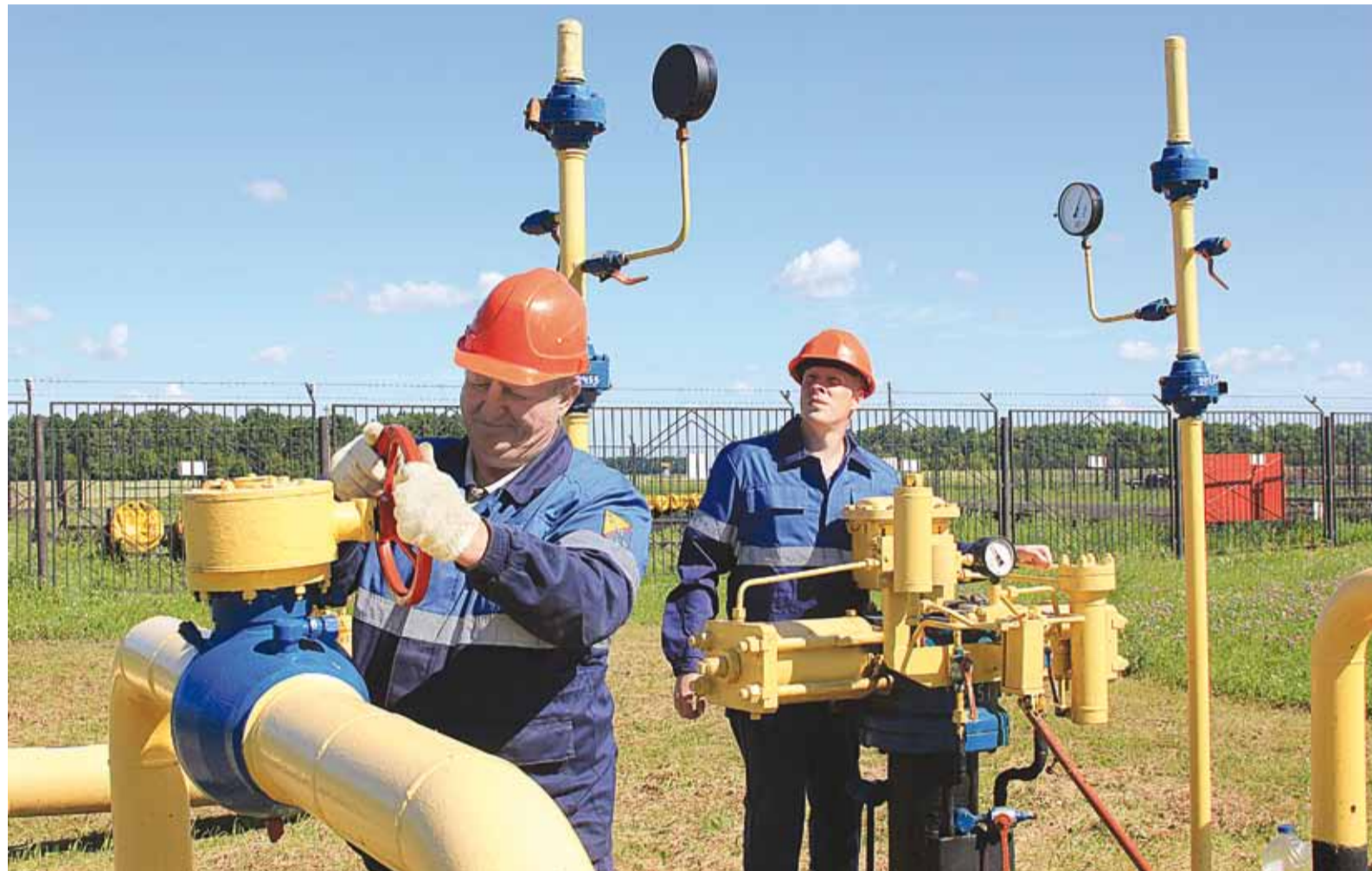
Линейные трубопроводчики службы ЛЭС Ю. Севостьянов (слева) и Н.Борюшкин переставляют трубопроводную арматуру и контролируют давление при проведении внутритрубной дефектоскопии на газопроводе Кирсанов - Тамбов
