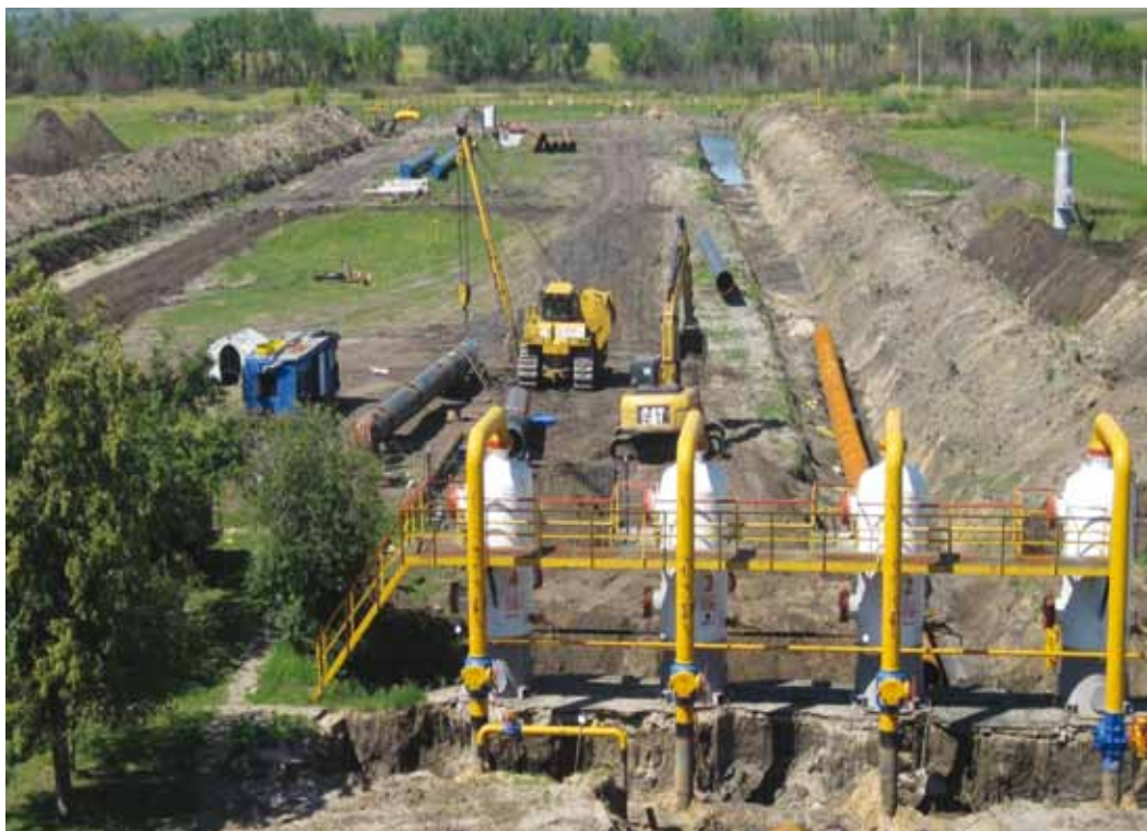
Капитальный ремонт технологических трубопроводов КЦ-1 Мещерского ЛПУМГ
