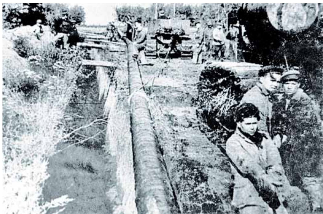
Расклад трубы на газопроводе близ станции Дубовская
