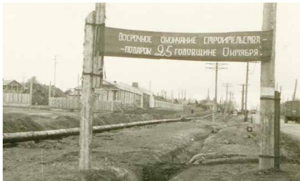
Протяженность газопровода «Елшанка - Саратов» 16 км, диаметр 325 мм
