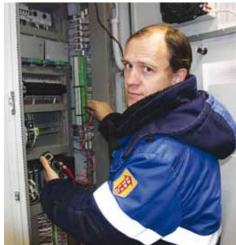
Инженер КИПиА В.Бывалкин проверяет защиту в системе автоматического управления ГПА
