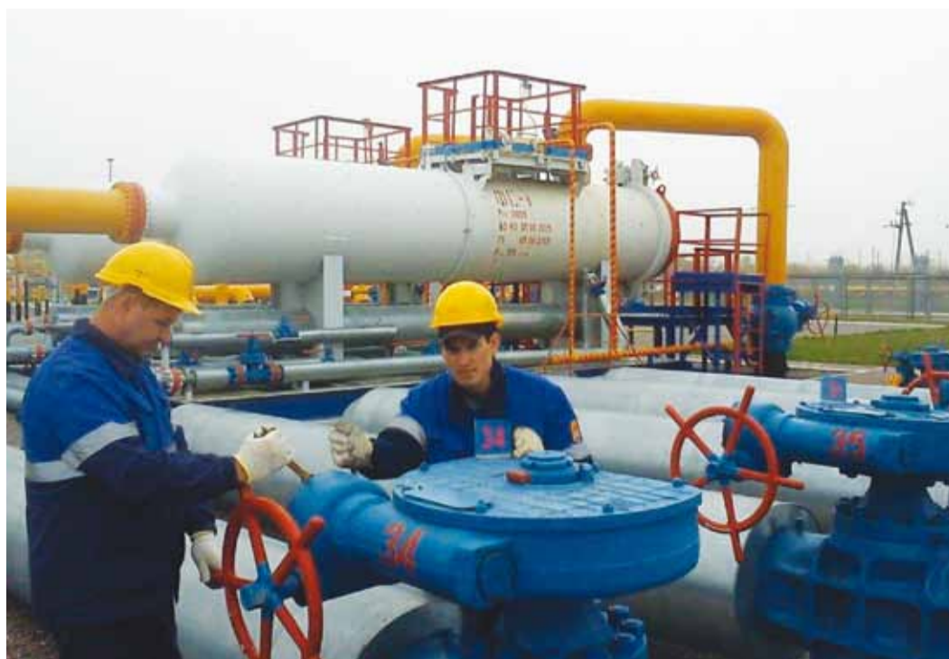
Оператор ГРС-2А С.Тимофеев и слесарь службы А.Цыплаков проводят техобслуживание запорной арматуры
