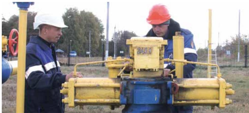
На линейной части газопроводов дел всегда много. Мастер ЛЭС А.Михалев (слева) и линейный трубопроводчик С.Кориков проводят ревизию трубопроводной арматуры.
