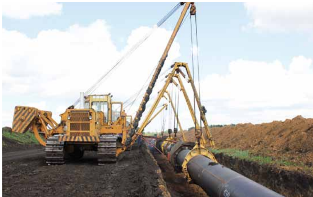
Газовые трассы Балашовского ЛПУМГ
