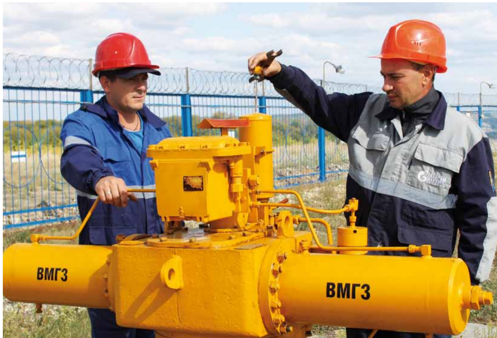
Линейные трубопроводчики Дмитрий Легков и Дмитрий Шейко проводят техническое обслуживание трубопроводной арматуры
