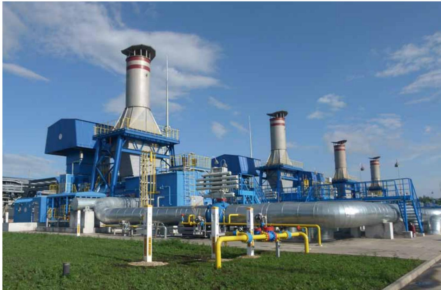
Задача по реконструкции компрессорного цеха №2 Екатериновского ЛПУМГ была успешно решена обществом в сжатые сроки – за полтора года. Обновленный цех оснащен четырьмя модульными ГПА-16 «Волга» с газотурбинным приводом 16 Мегаватт, другим высокотехнологичным оборудованием. С января этого года цех работает в трассу, бесперебойно обеспечивая транспорт газа по газопроводу «Уренгой - Новопсков».
