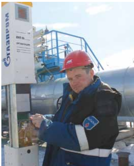
Обслуживание контрольно-измерительного пункта на КЦ-2
