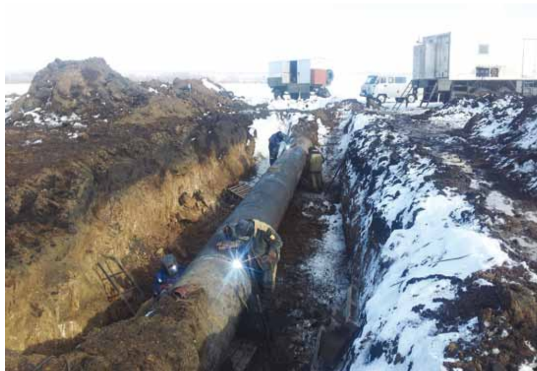
Работы на газопроводе Мещерского ЛПУМГ
