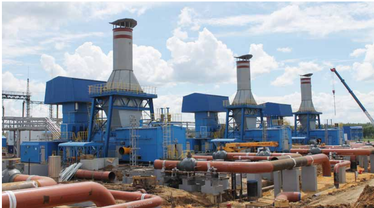
Строительство компрессорного цеха Екатериновского ЛПУМГ в самом разгаре
