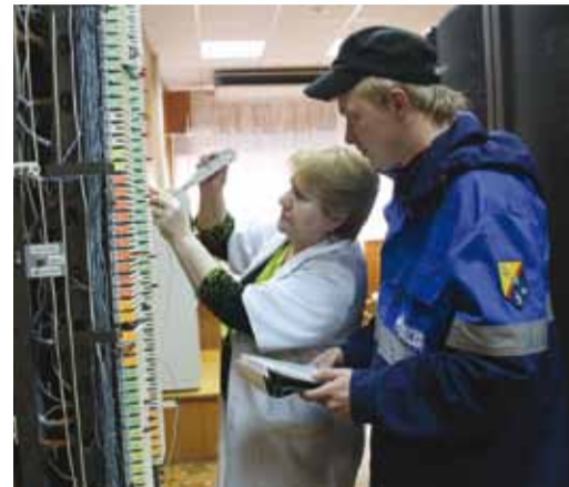
Электрмеханик Г. Глухова работает в службе связи со дня основания КС. Она передает свой богатый опыт молодому электромонтеру Ю. Феоктистову. Г. Глухова и Ю. Феоктистов проводят проверку абонентских линий.
