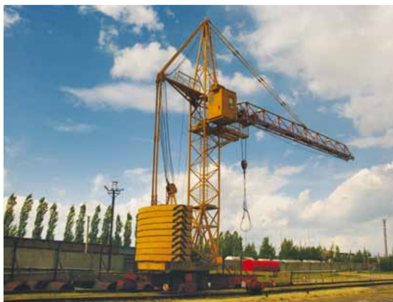
Идут разгрузочные работы
