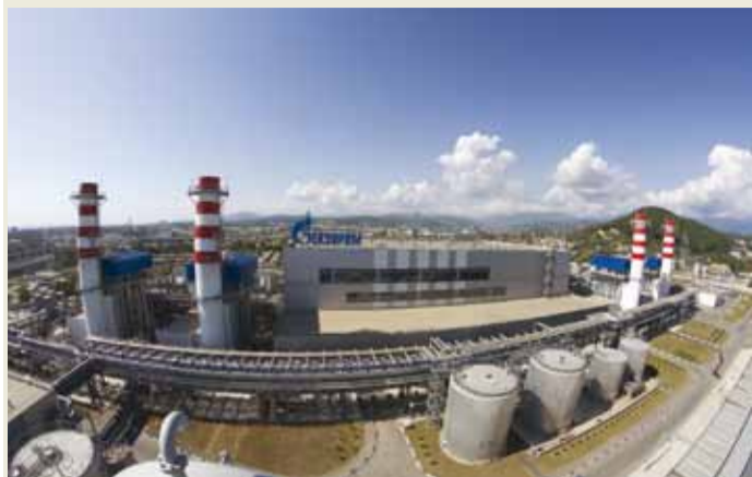
Олимпийские объекты, построенные ОАО «Газпром»: Адлерская ТЭС
