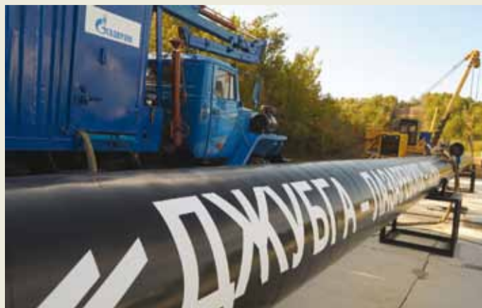
Газопровод «Джубга - Лазаревское - Сочи»
