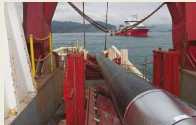
Прокладка морской части газопровода
