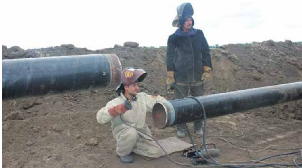
Ремонтные работы на газопроводе-отводе на ГРС «Дергачи» ведутся совместными силами ЛПУМГ и УАВР
