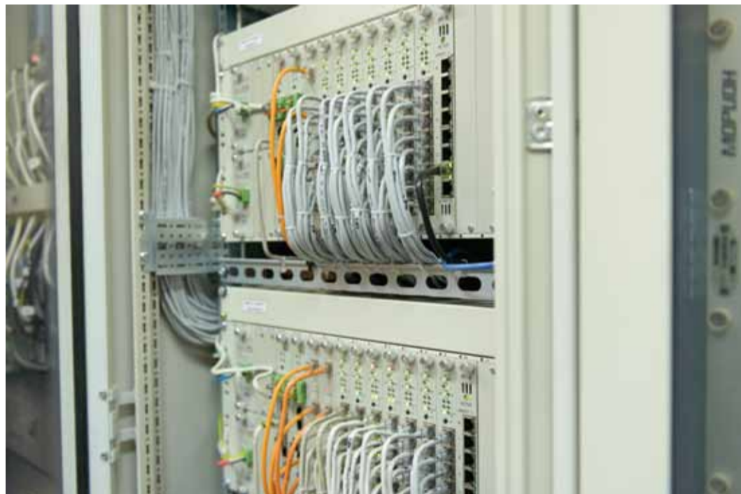
Повышение надежности связи – главная цель капитального ремонта
