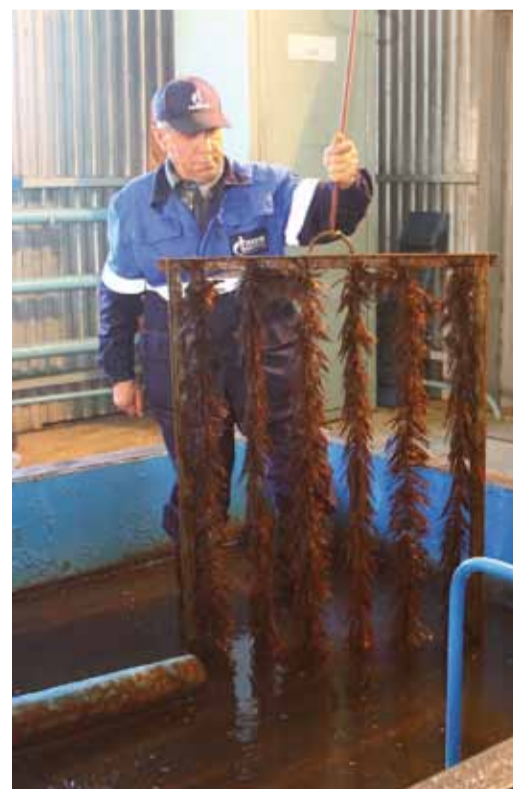
Очистные сооружения «Нептун-100» в Петровском ЛПУМГ были введены в эксплуатацию 7 лет назад и успешно выполняют возложенные на них функции. Машинист насосных установок Анатолий Нурков надежно обслуживает вверенное ему оборудование
