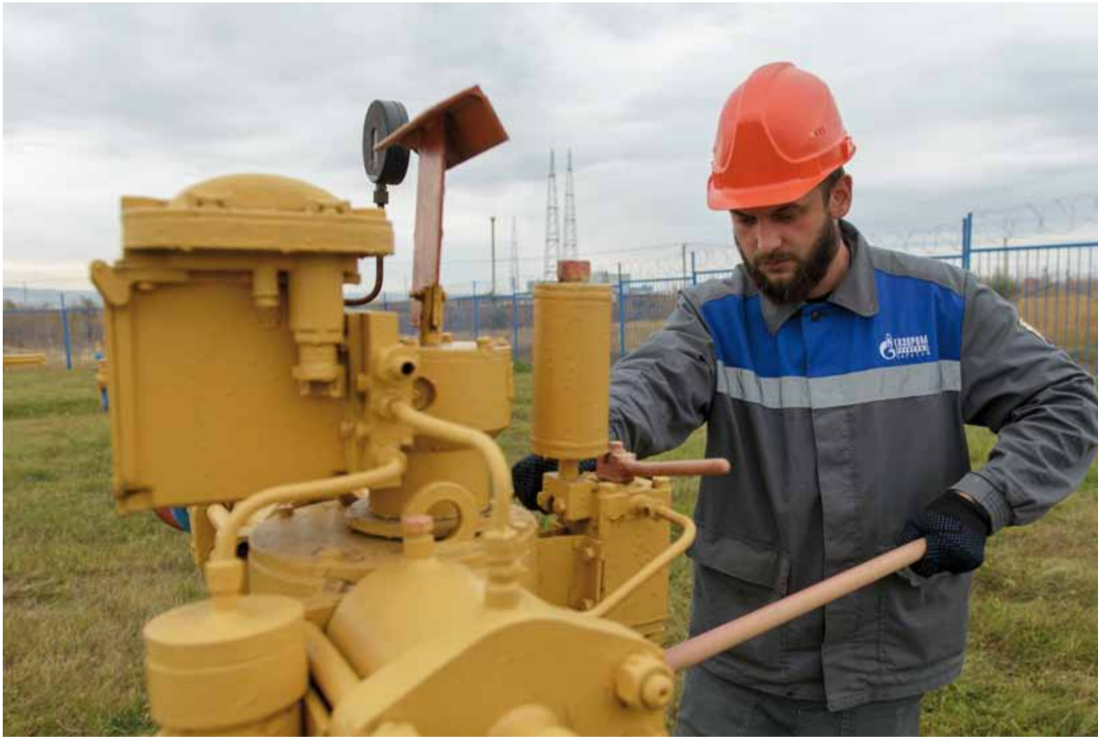
Подготовка крановой площадки к периоду отбора газа. Трубопроводчик линейный 5 разряда Сторожевского ЛПУМГ Дмитрий Аверьянов выполняет перестановку запорной арматуры
