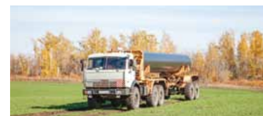
Очередная труба для ремонта прибыла на объект
