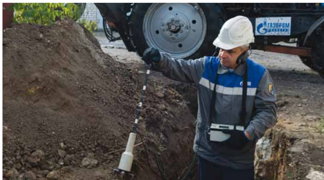
Обрыв кабельной линии подтвержден, пора приступать к устранению неполадки
