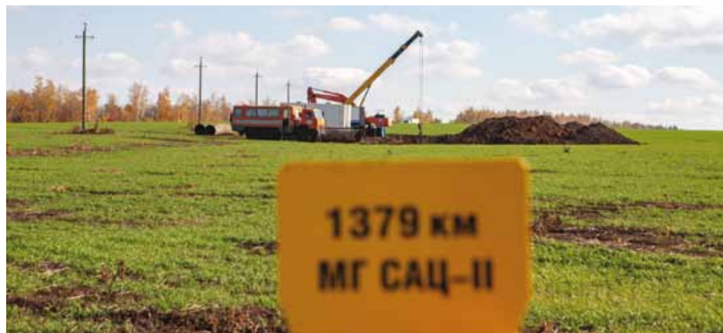
На данный момент выполнена замена около половины всех выявленных дефектных участков МГ САЦ-2
