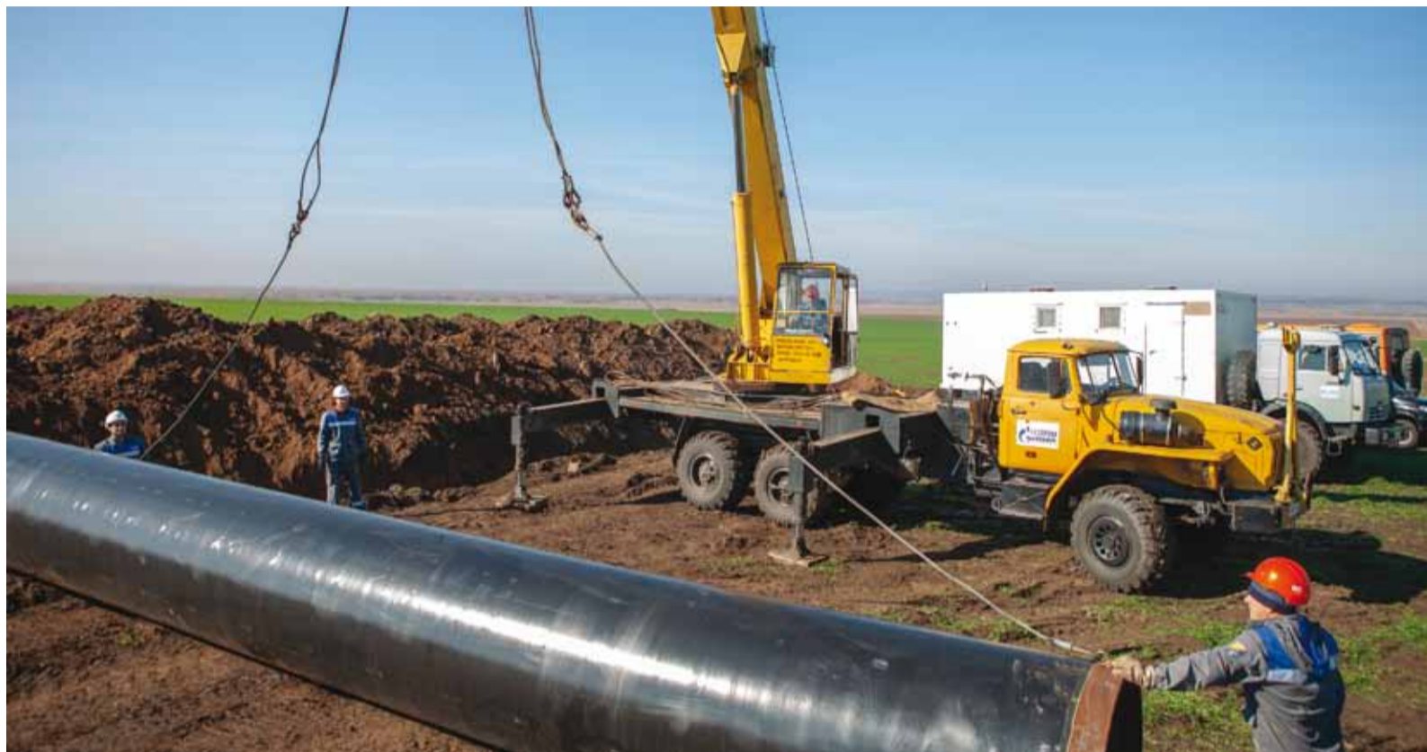
Ремонт МГ САЦ-2 проводится по результатам внутритрубной дефектоскопии
