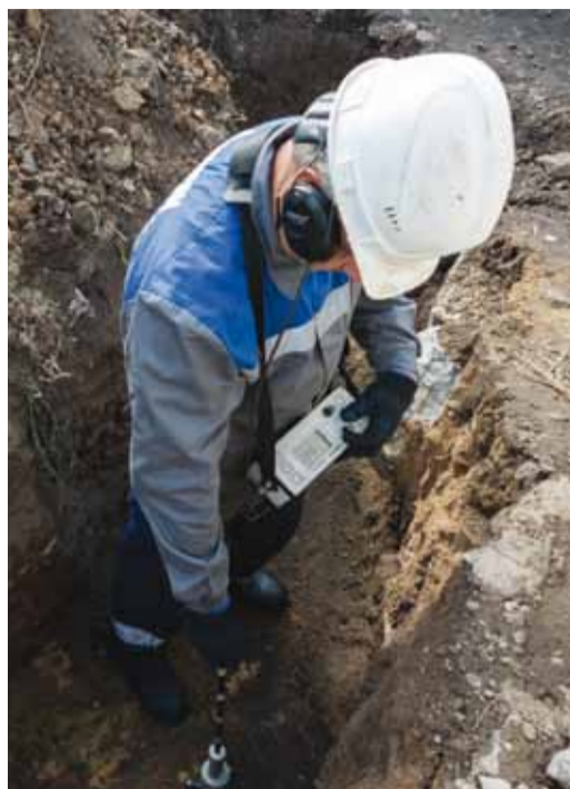
Процесс поиска места повреждения кабеля
