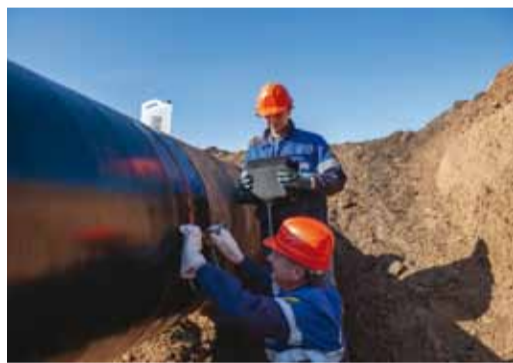
Ультразвуковое обследование сварного шва
