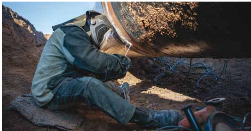
На объекте работают две сварочно-монтажные бригады УАВР
