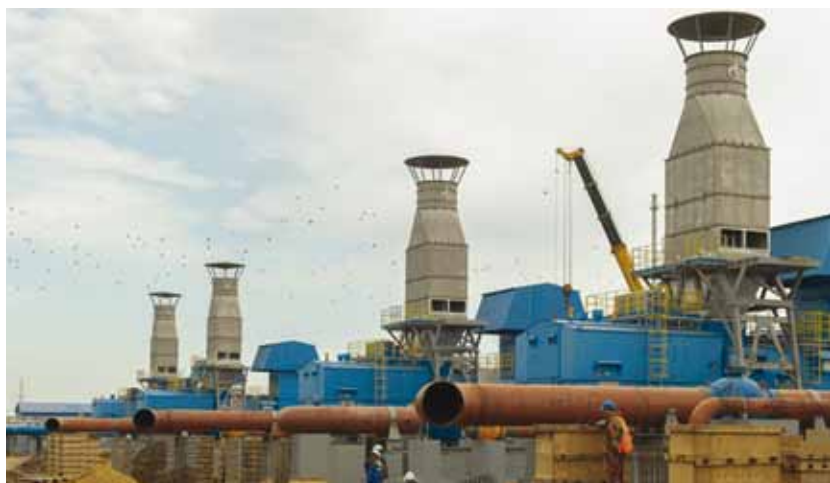
Строительная площадка компрессорного цеха №4 КС «Петровск»
