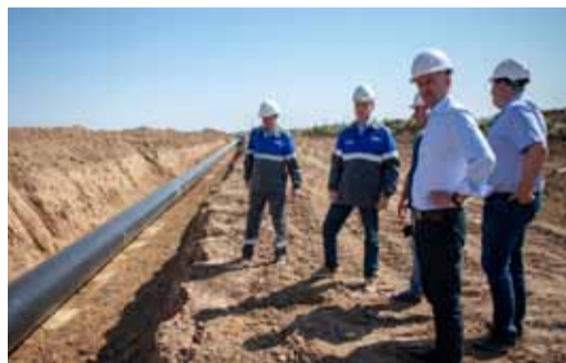
Капитальный ремонт МГ САЦ-4-1
