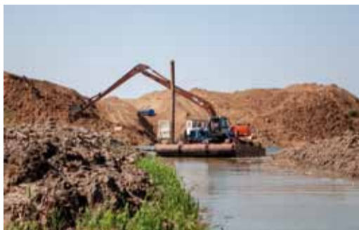
Ремонтные работы на реке Большой Узень
