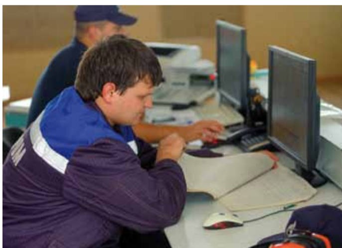
Главный щит управления компрессорного цеха № 27. Здесь непрерывно идет фиксация данных о параметрах работы газоперекачивающих агрегатов.
