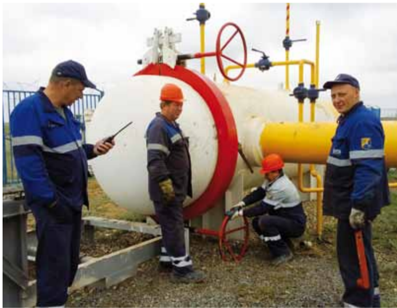
Проведение внутритрубной дефектоскопии на газопроводе «Союз»
