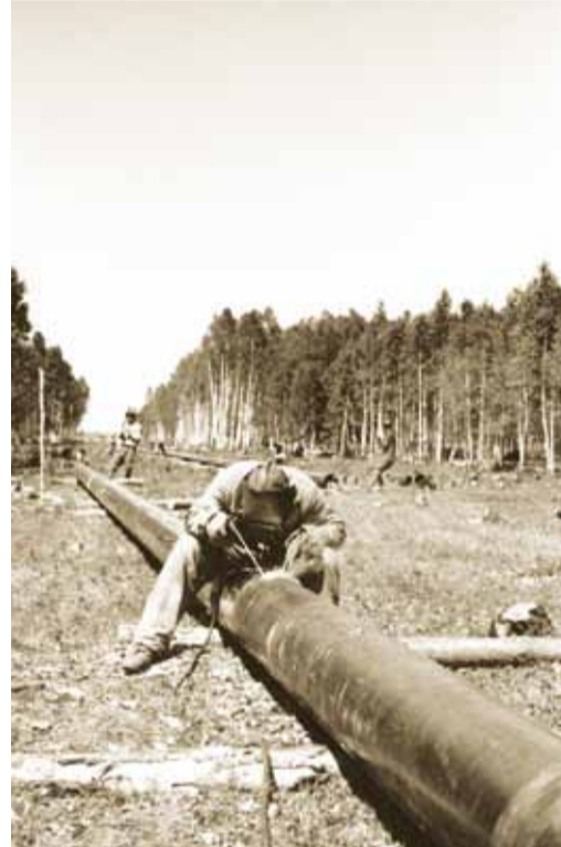
Сварка труб газопровода «Саратов – Москва». 1945 г.
