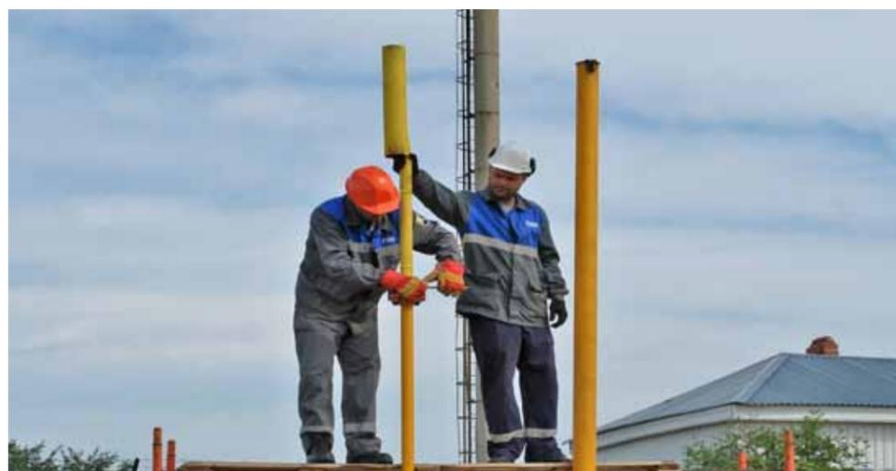
Оголовок сбросной свечи предназначен для монтажа на сбросном и продувочном трубопроводе для стравливания газа в атмосферу, в случае аварии или в плановом порядке (при проведении ремонтных работ).
