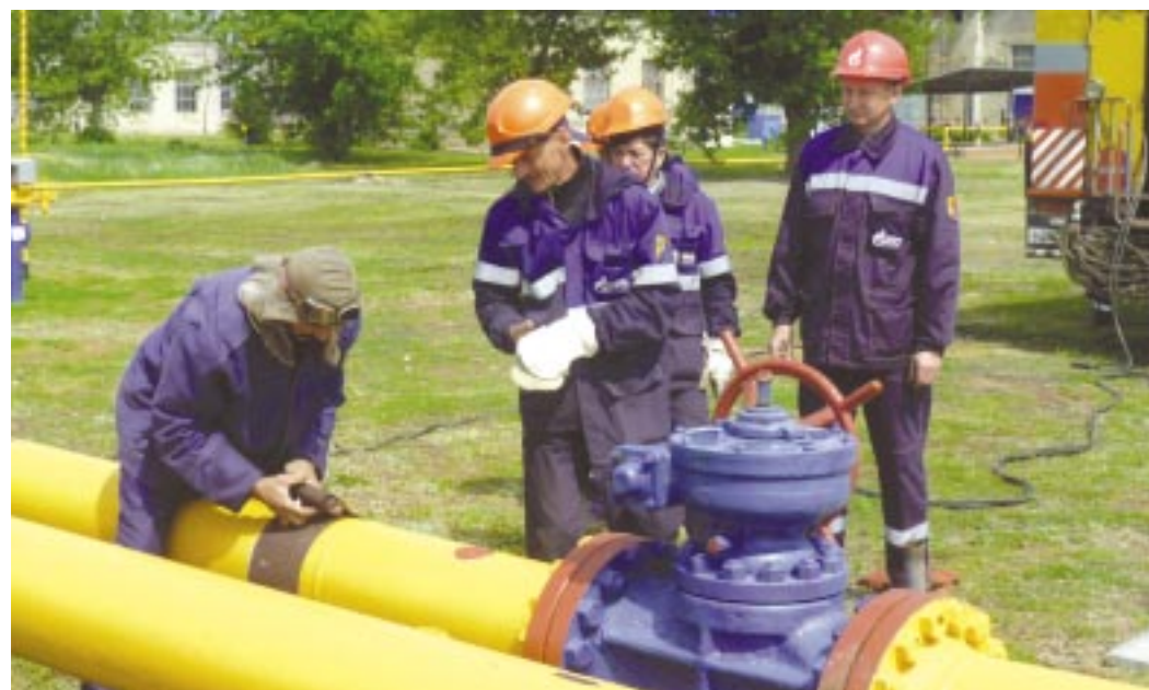
Аварийно-восстановительная бригада Кологривовской промплощадки производит работы на «разрушенном взрывом» технологическом оборудовании. Фото репортаж подготовили В.Орел, А.Оглоблин, В.Ершов
