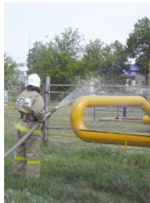
Расчеты добровольной пожарной дружины промплощадки и ПЧ-60 ведут локализацию возникшего пожара
