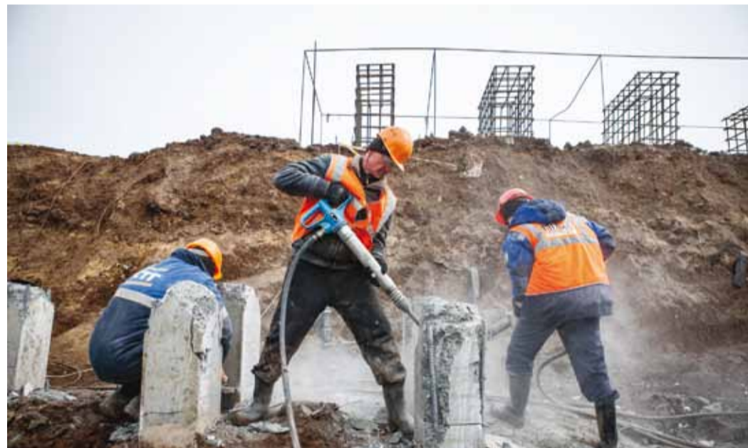
Распушевка свай под выходной коллектор цеха
