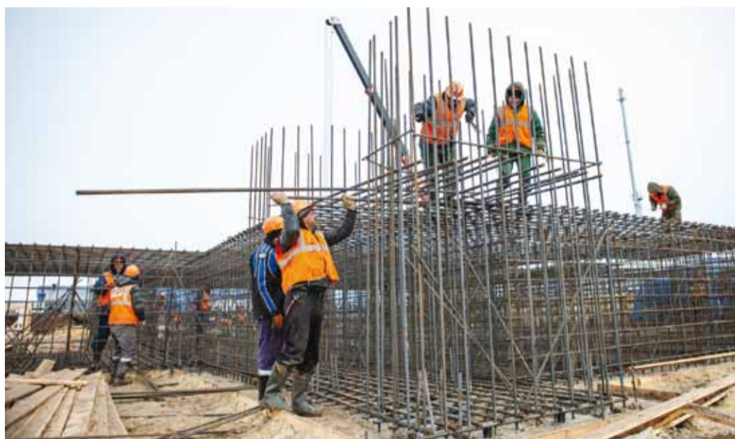
Установка армокаркаса под ГПА второй группы
