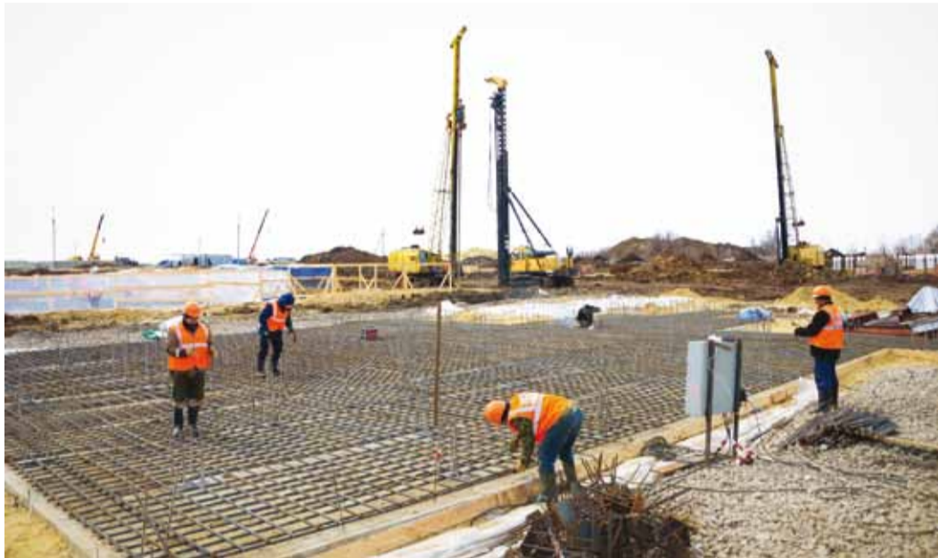
Установка армокаркаса под ГПА №5
