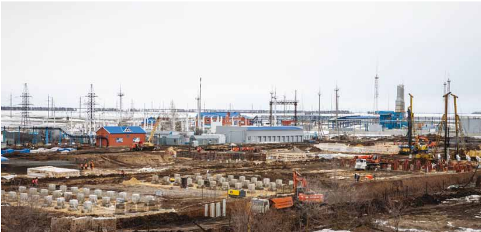
Строительная площадка КС-25
