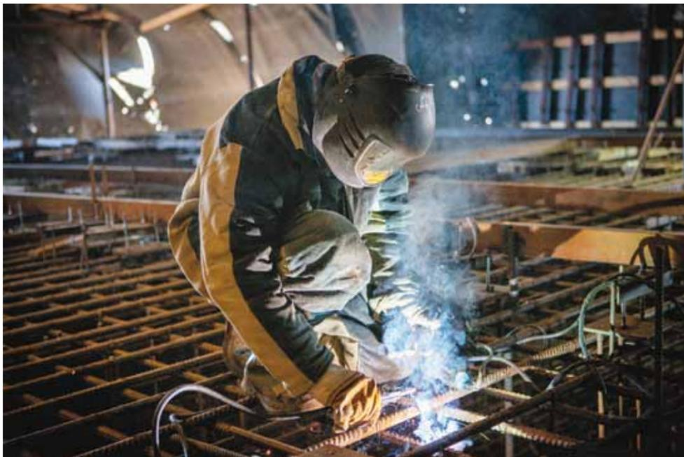
Выполняется монтаж армокаркаса фундамента ГПА №5
