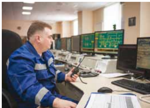
Инженер по ЭОГО Приволжского ЛПУМГ Альберт Немченко производит опробование кранов линейной телемеханики совместно с линейно-эксплуатационной службой
