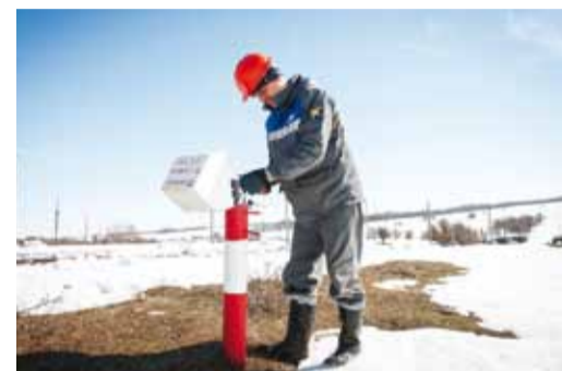
Монтер службы защиты от коррозии Сторожевского ЛПУМГ Леонид Хабаров выполняет регулировку режима защитного потенциала магистрального газопровода Сторожевск-Петровск в связи с изменением влажности грунта
