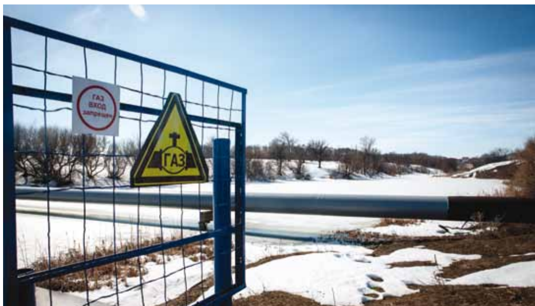
Воздушный переход магистрального газопровода Сторожевка-Петровск через пруд
